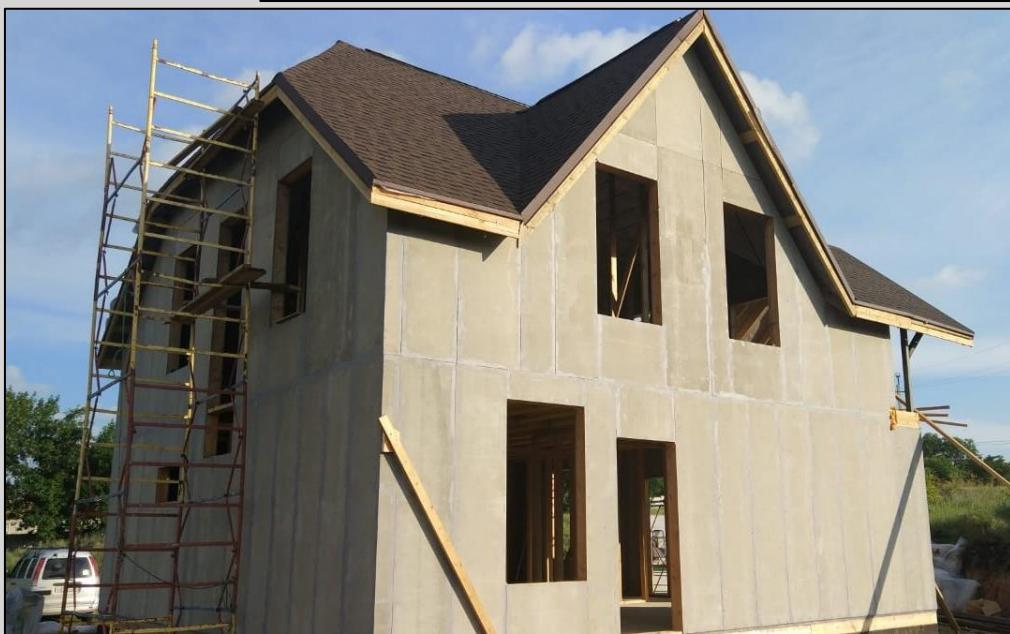
**ФОТО 7 Кровля с покрытием гибкой черепицы Шинглас**
