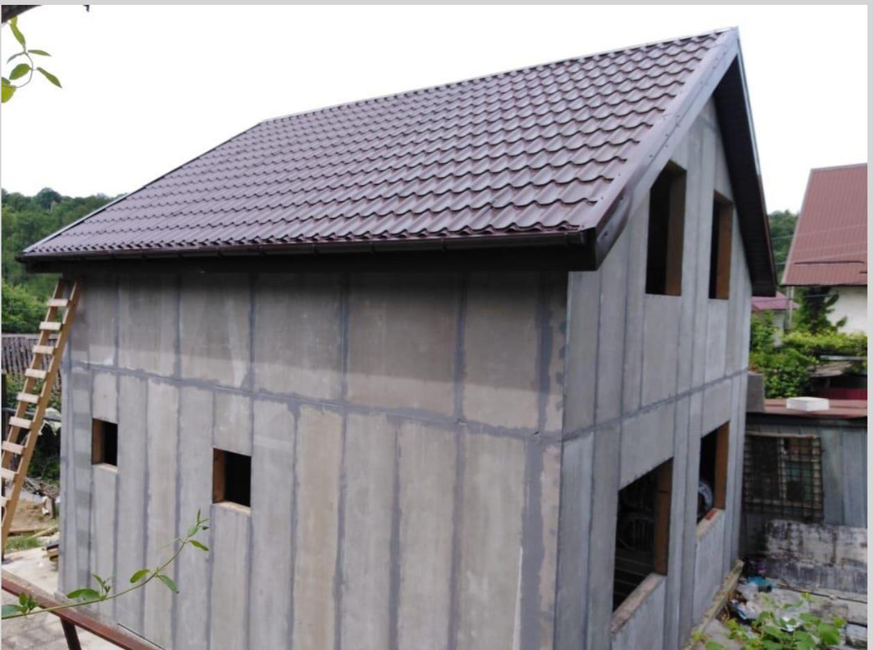
**Фото 8 Кровля с покрытием металличерепицы**
