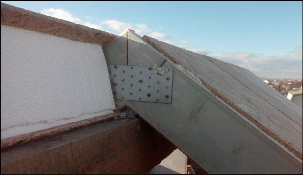
**ФОТО 5 Узел конькового стыка кровельных панелей**
